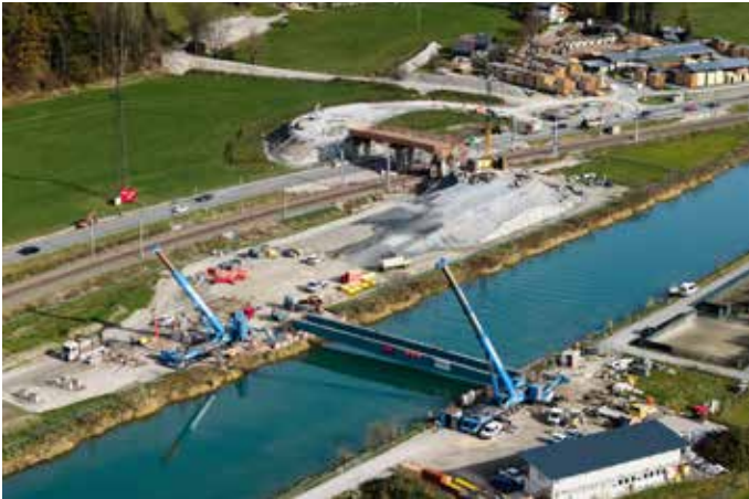
Bei der Verkehrslösung Gries läuft alles nach Plan
